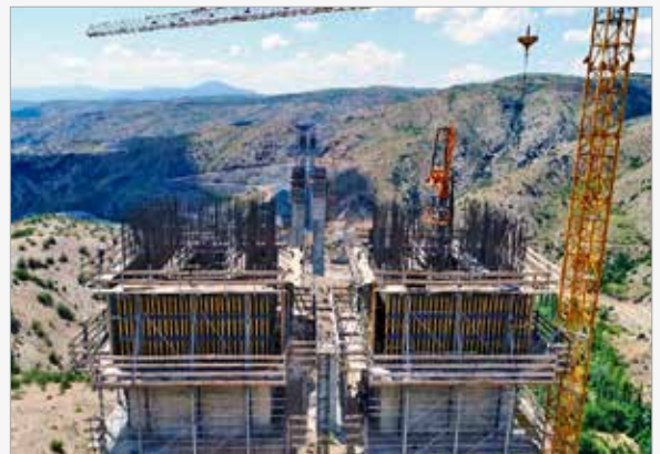
Eyiste Viaduct Project
